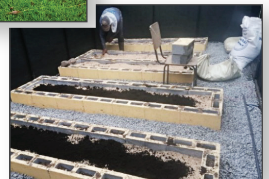
Proyecto: Construcción de un invernadero en el Cen-Cinai de Peñas Blancas.
